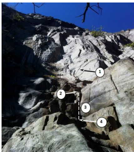
Figura 1: 1) Zona dove verosimilmente è stata inserita la maglia rapida. 2) Zona dove verosimilmente è iniziata la caduta. 3) Caduta stimata 5-10 m. 4) Zona di impatto col suolo. Fonte: Polizia Cantonale, Sgtc Castellani M.
